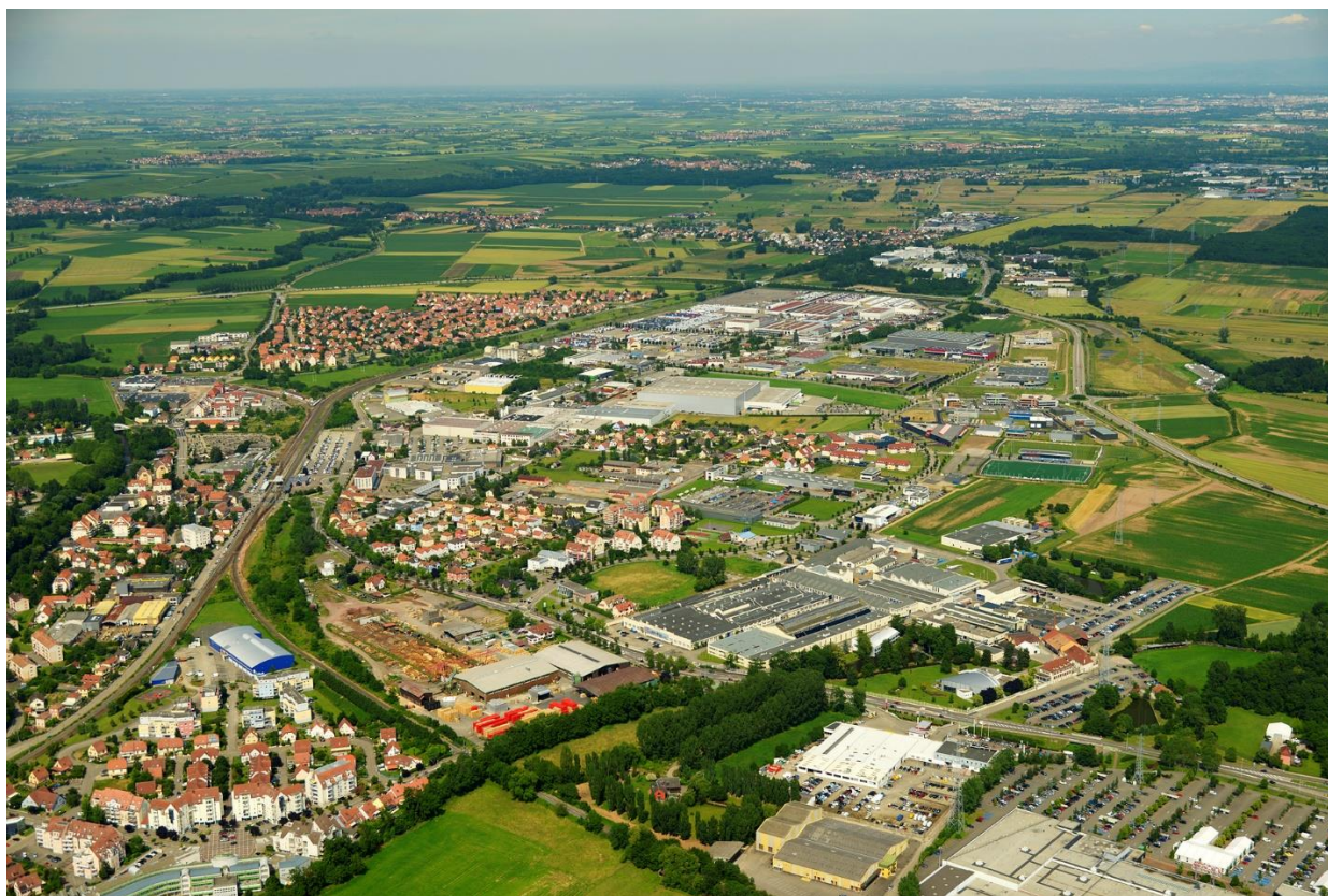
Photographie n°28. Des formes urbaines dilatées qui empiètent sur le paysage naturel de la vallée
