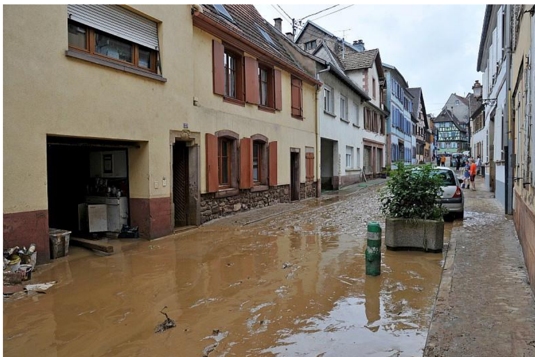
Photographie n°2. Wasselonne après la coulée d'eaux boueuses du 7 juin 2016
