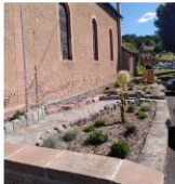
Le terrassement au pied de l'église avec la citerne au fond.
