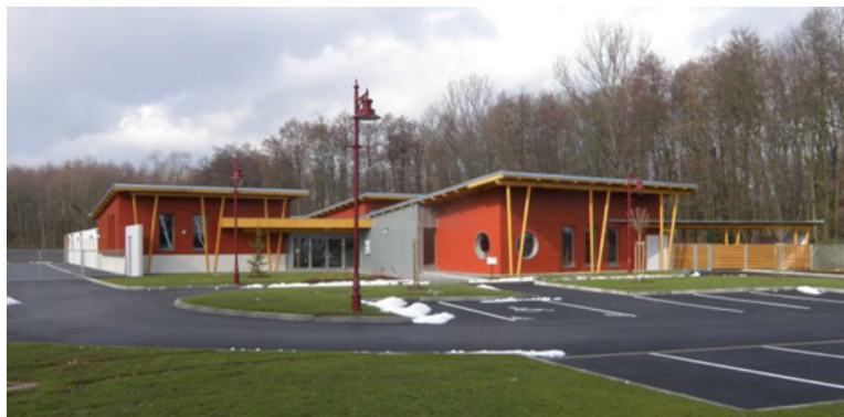
La nouvelle école d'Avolsheim avec son ossature bois se trouve à la sortie est du village.
