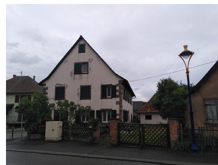
L'ancien bâtiment avant les travaux.
