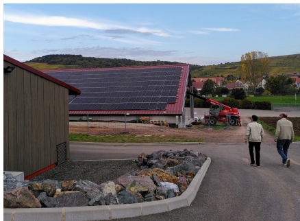
L'installation photovoltaïque est juste à côté de la chaufferie bois qui alimente le réseau de chauffage de la commune (au premier plan à gauche).
