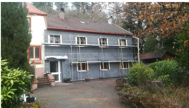
L'isolation par l'extérieur sur la grande maison - © maTerre
